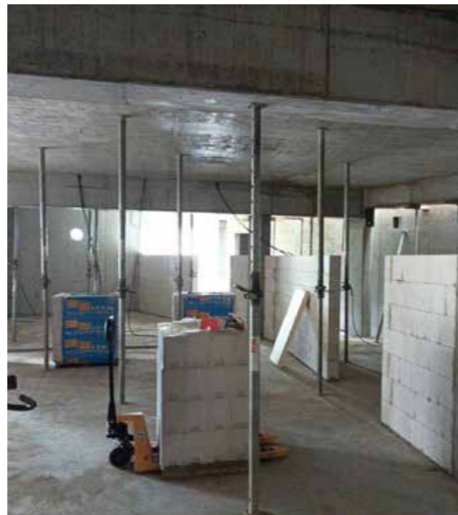
Mauerwerksarbeiten in der Parkgarage
