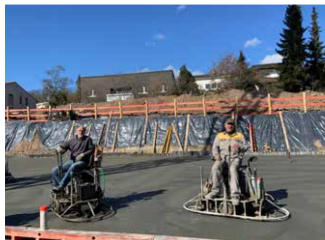
Flügelglätten - Bodenplatte Parkgarage
